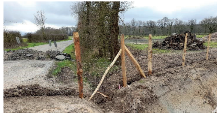
Figure 171 : Illustration de mise en défens en phase chantier
